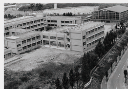
完成間もない校舎
